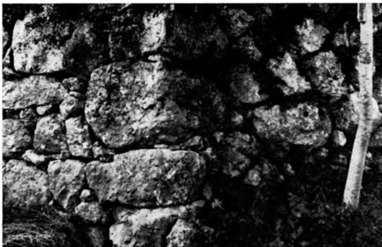
Fig. 26 Tessitura d'angolo nei terrazzamenti centrali.
