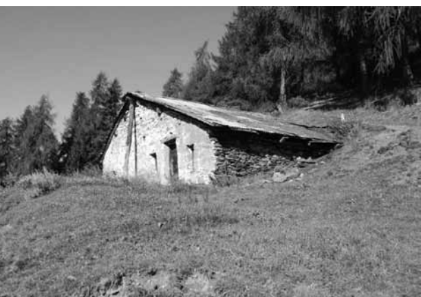
Fig. 5 - Predalbuino: esempio di struttura storica, in muratura, incassata nel terreno e con ripetto antistante
