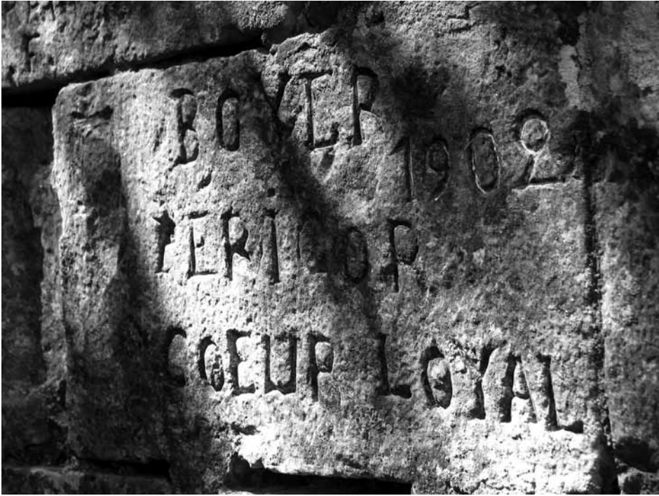
Fig.6 – Remarque d’Abel Boyer (1902) derrière la chapelle des Parisiens
