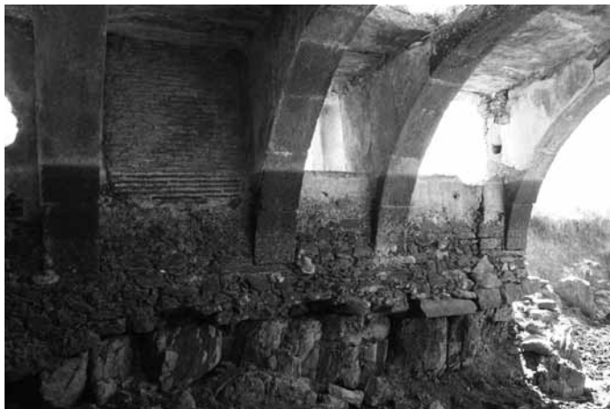
Fig. 4 - Detalle del interior de la nave y de los arcos diafragma (foto del autor).
