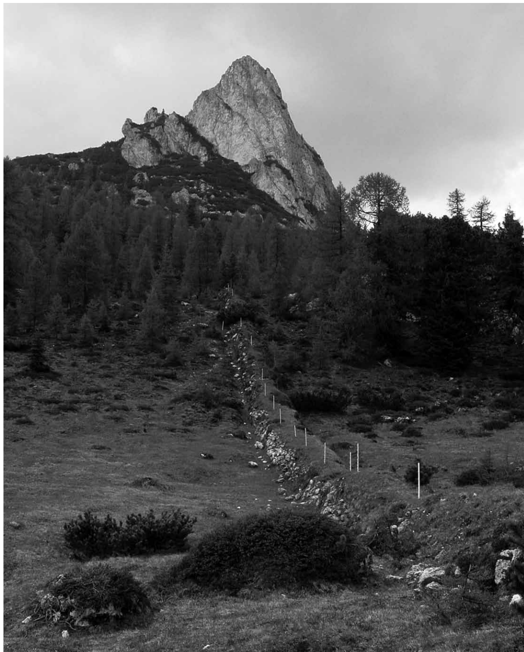
Panoramica del muro del Giau
